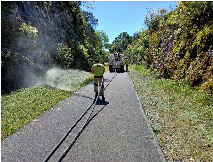
Opération de semis hydraulique, et effet couvrant de la cellulose dans laquelle sont incorporées les graines du mélange végétal.
